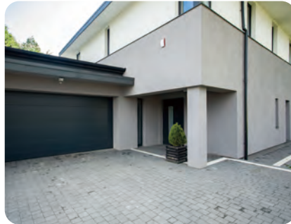
Entrada de garaje
